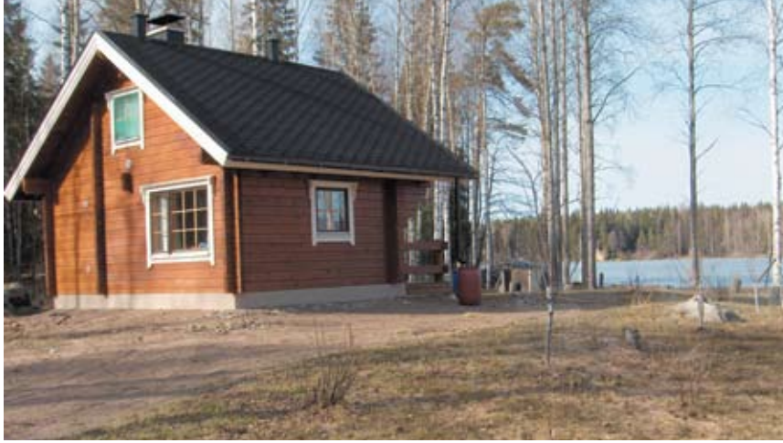
Hirsimökki kuuluu perinteiseen suomalaiseen maisemaan. Tässä lamellihirttä, mikä on helpompi puhdistaa ja likaantuu myös vähemmän.
