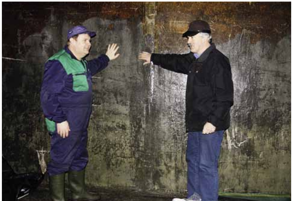
▲ Tarja ja Mauri Mustosen tilalla Kaavin Sivakkavaarassa 1991 rakennetut laakasiilot pinnoitettiin viime kesänä tilan omana työnä. Seinäpinnat käsiteltiin Solmasterin epoksinnoitteella. Pinnat puhdistettiin höyrypesurilla. Pesun jälkeen syöpyneet kohdat täytettiin sementtipohjaisella betonipintojen korjaustasoiteella. Pinnoitus tehtiin kahdessa vaiheessa: ensin telattiin tartuntakerrokset, sen jälkeen laitettiin vielä uusi pinnoitekerros. Mauri Mustonen ja Heikki Niskanen tutkivat rehun alta paljastuneen seinäpinnan hyvää kuntoa.
