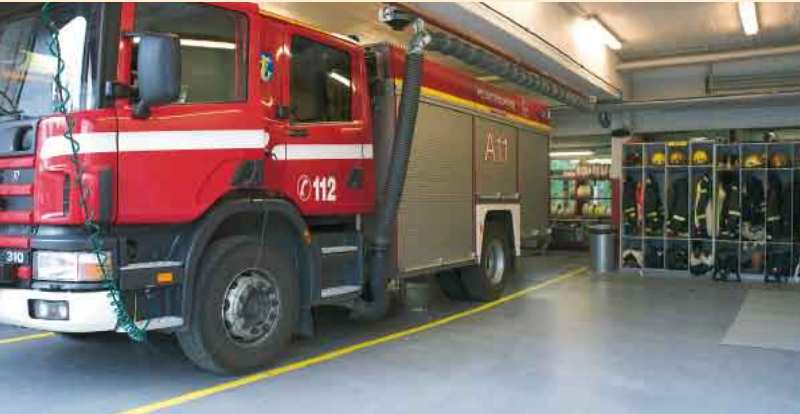
Uutta ja kestävä Vääksyn paloaseman lattiapintaa. Akryylilakalla viimeistelty pinta on erittäin helppohoitoinen.
